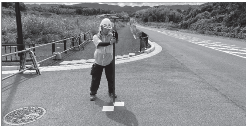
UAV 標定点の設置作業
