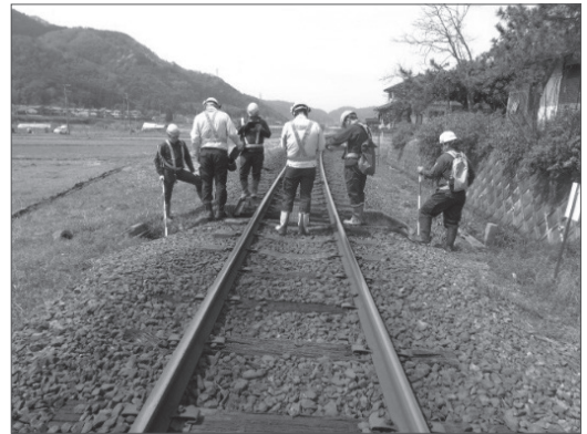
写真1：土木定期検査作業状況
