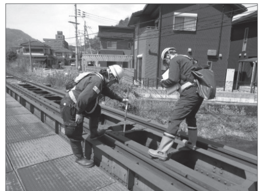
写真2：土木定期検査作業状況
