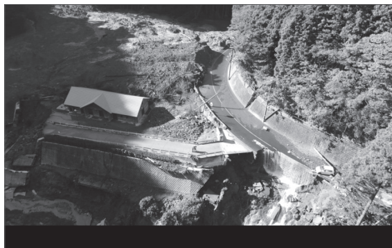
浸水した道路 (UAV 撮影)
