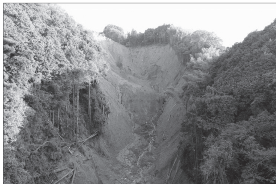
崩壊した斜面 (UAV 撮影)
