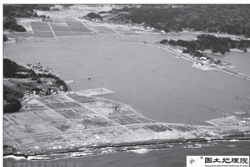
空中写真（斜め写真） (井田川周辺：南相馬市)
