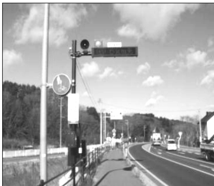
図－8 津波情報提供装置の設置例
