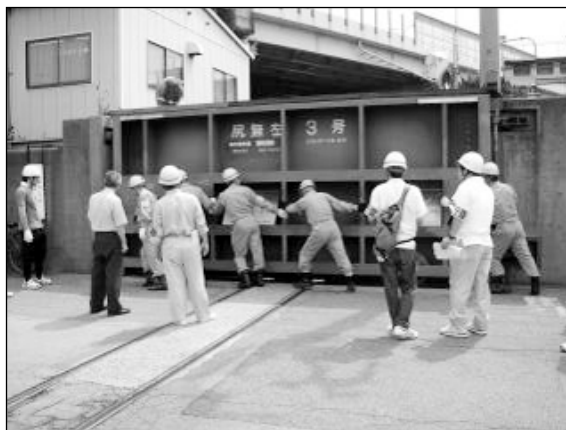
図－２ 防潮鉄扉（尻無川左岸）
