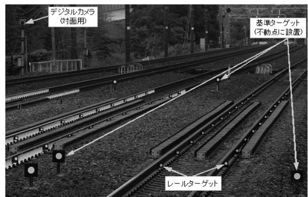
写真 - 1 望遠レンズで見た線路
