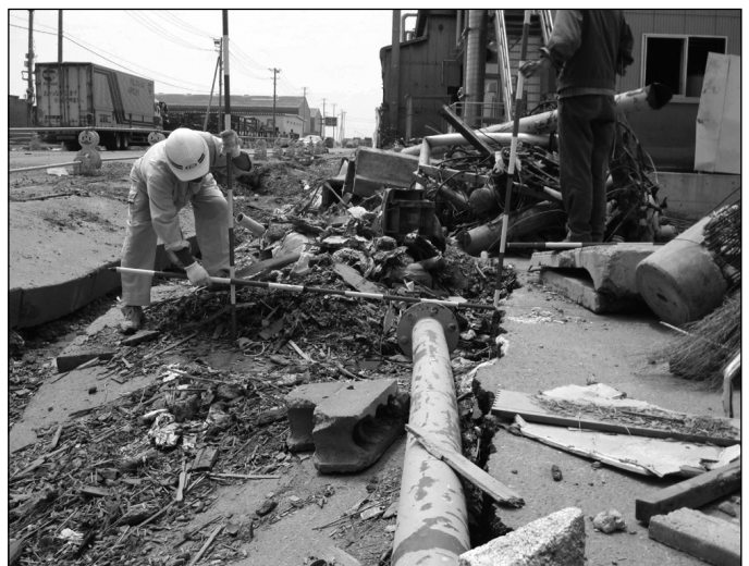
道路の被災状況(H23/5/26)
