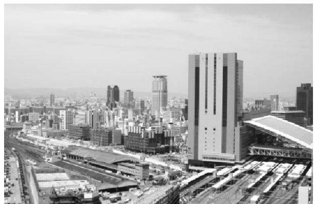
写真2 開業した大阪ステーションシティと大阪駅と工事中の1期先行開発地区
