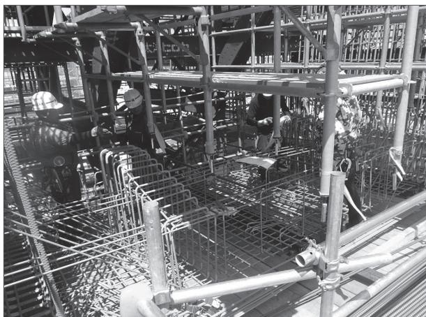
先組架台での鉄筋組立状況鉄筋吊込状況
